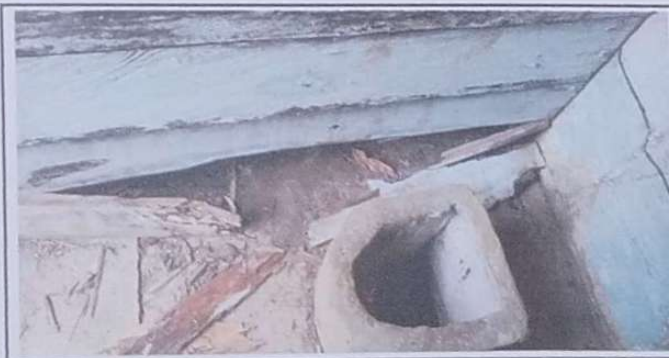
Foto 5: Se observa la separación interna de los baños, esto se cambiará por blok.
