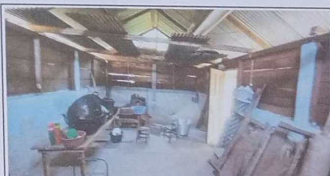
Foto 4: En el interior de la cocina se construirá un fogón de blok ya que la de madera se eliminó porque ya no sirve y provoca accidentes para quienes cocinan.
